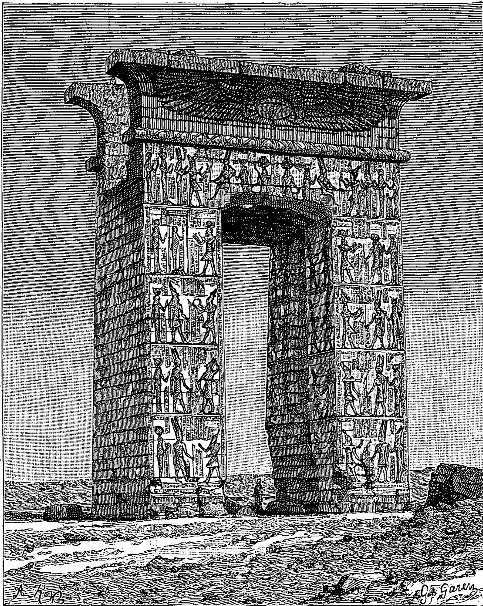
RUINES DE THÈBES. — PROPYLONE OU PORTE DU NORD.
